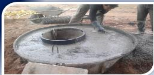
ساخت دال و فوتینگ منهول ها بصورت پیش ساخته و متمرکز
