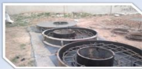
ساخت دال و فوتینگ منهول ها بصورت پیش ساخته و متمرکز
