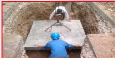
ساخت دال و فوتینگ منهول ها بصورت پیش ساخته و متمرکز
