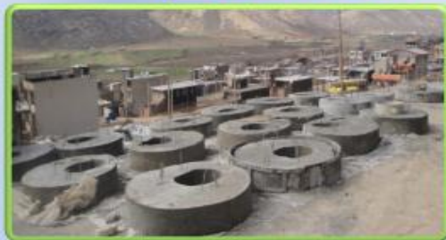
ساخت دال و فوتینگ منهول ها بصورت پیش ساخته و متمرکز
