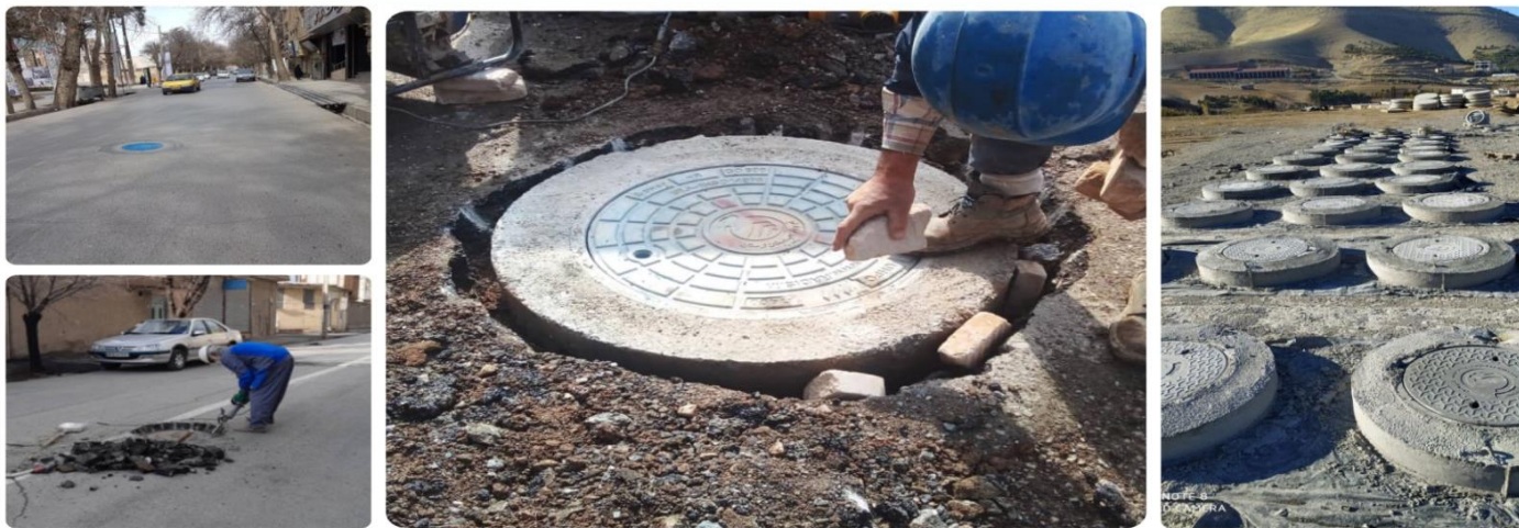
همسطح سازی منهول ها با استفاده از دالچه های پیش ساخته و دريچه های کامپوزيت
